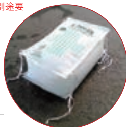
土No袋 箱型 完成状態
